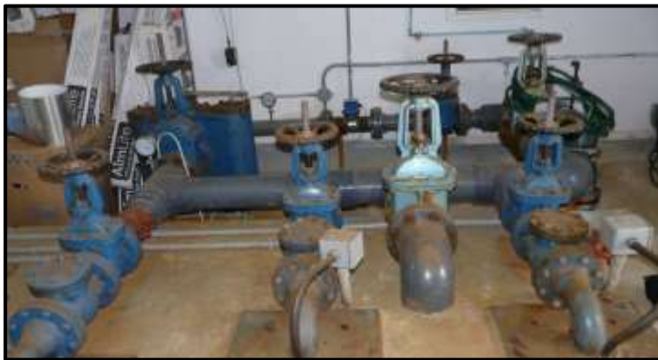
Rigolet pump house
